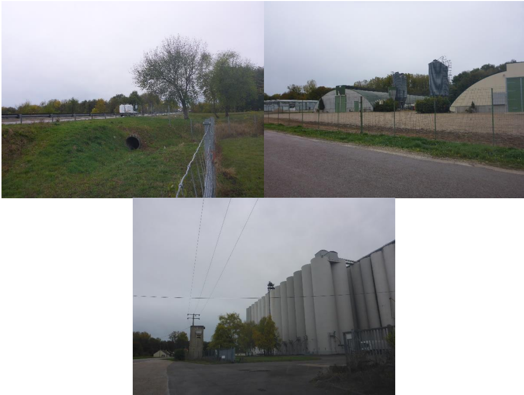
Figure 9 : Photos des installations présentes dans le PPE
